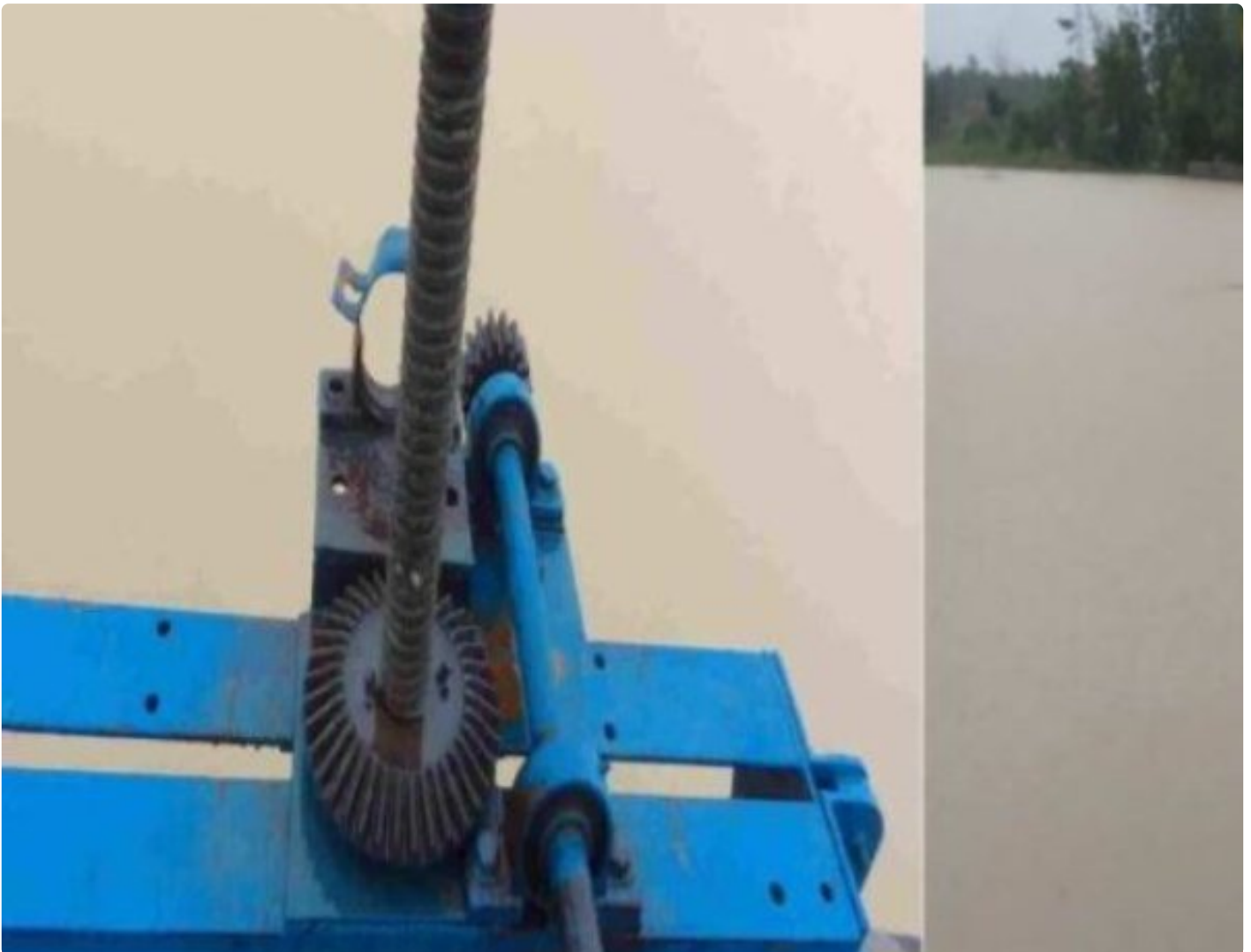
Pintu air Albaret Simpang Mesuji
